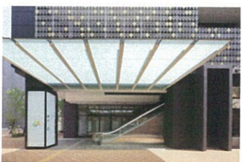
D棟・エントランス
