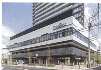
D棟・低層部(南西側)
