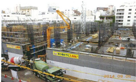
D街区工事
